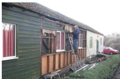
Rampisham VH (before cladding)
